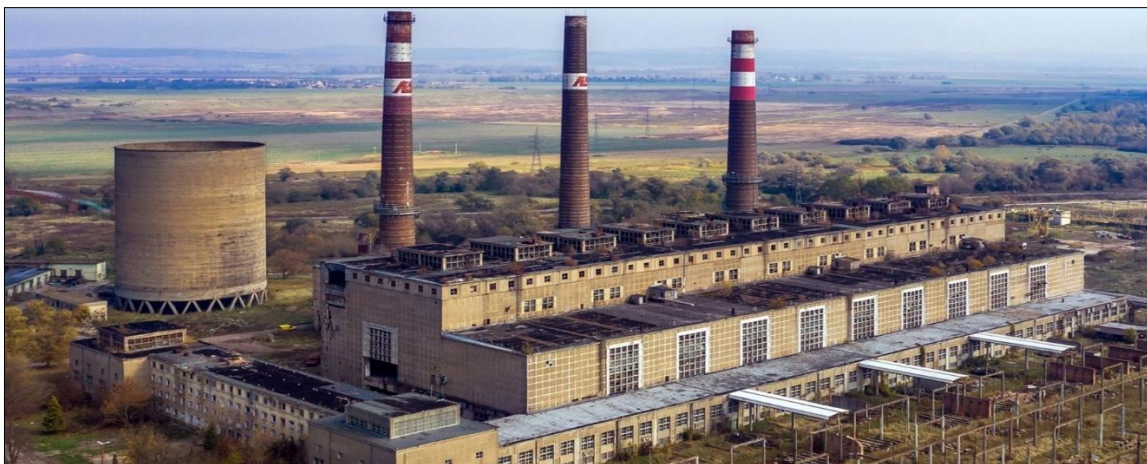
Berentei Erőmű, a tetején zöldellő bozóterdővel. 2019. Forrás: Wikimedia Commons
