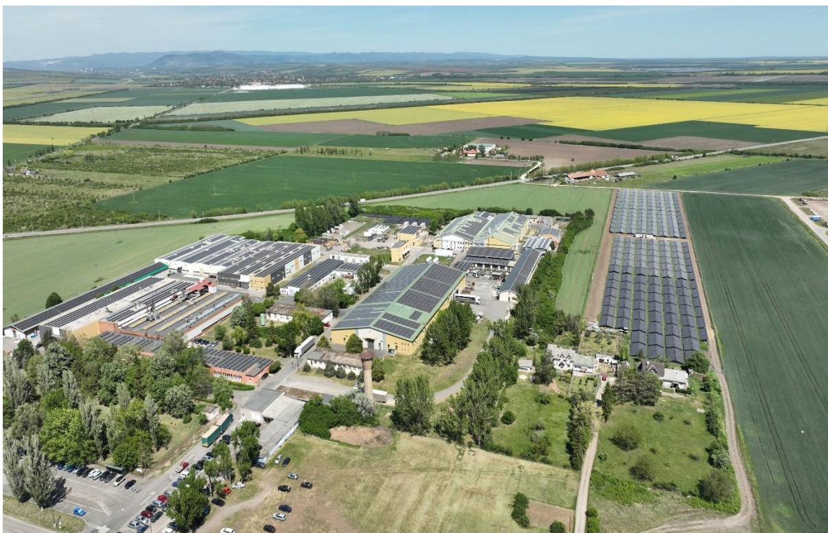
Napelempark csarnoktetőkön és talajra telepítve
