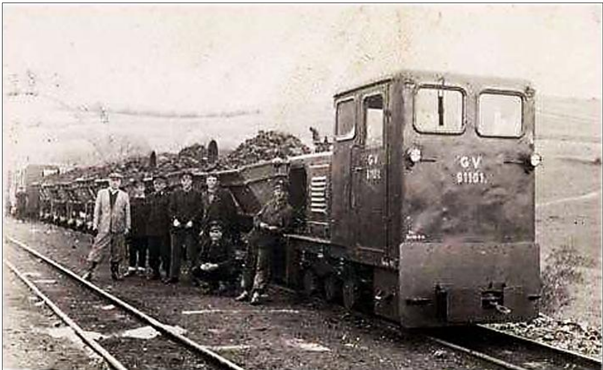
Az 1921. februárjában megalakult Érseki Bánya és Ipartelepek Rt. Szarvaskő területén, az Almár-völgy felső részén a Töviskes-hegy oldalában kihajtásra került a Szent János táró . A szén elszállítására az Eger-Putnoki vasúthoz csatlakozva 5,5 km hosszú keskeny nyomközű vasút működött. (Fotó: kisvasut.hu)
