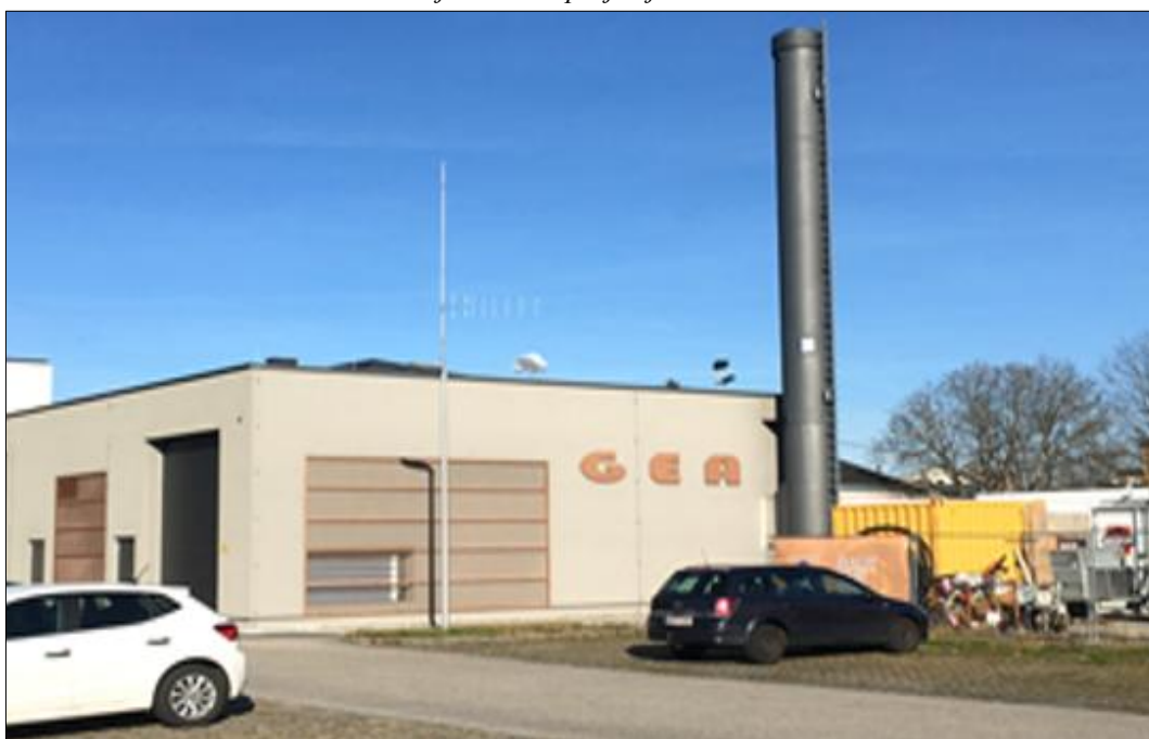
A Geotermikus törpe-erőmű épülete Altheimben.
