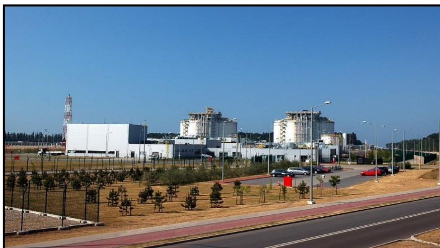
Świnoujście LNG terminál
