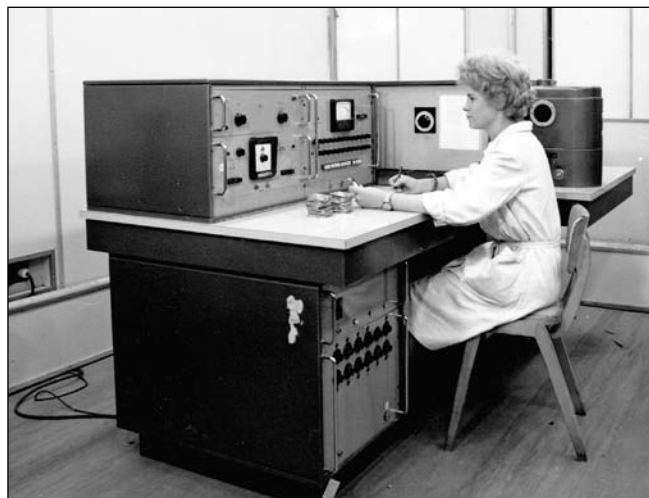
■ 8. kép. Spektrométer a Színképelemző Laboratóriumban (1965)
