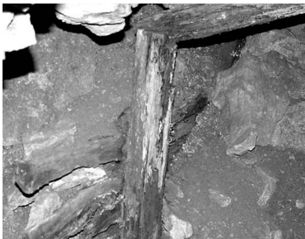
2. ábra: Középkori tóró maradványa (Fotó: Rozložnik Ondrej)
