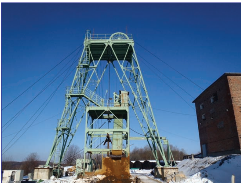
Mátraszentimrei aknatorony, döntőberendezéssel
